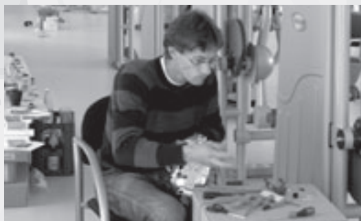
Einer von zahlreichen ehrenamtlichen Helfern: André Meister montiert die Beleuchtung im KraFit-Raum
