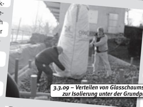
3.3.09 – Verteilen von Glasschaumshotter zur Isolierung unter der Grundplatte
