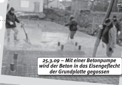
25.3.09 – Mit einer Betonpumpe wird der Beton in das Eisengeflecht der Grundplatte gegossen
