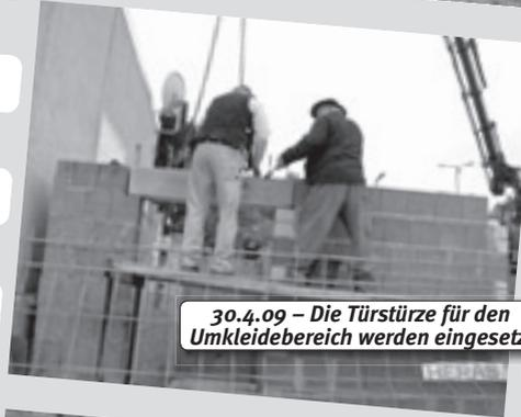
30.4.09 – Die Türstürze für den Umkleibereich werden eingesetzt
