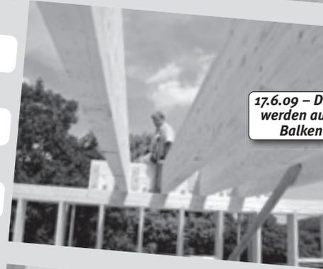
17.6.09 – Die ersten Dachsparren werden aufgesetzt. Einer dieser Balken wiegt etwa 900Kg
