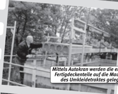
Mittels Autokran werden die ersten Fertigdeckenteile auf die Mauern des Umkleidetraktes gelegt
